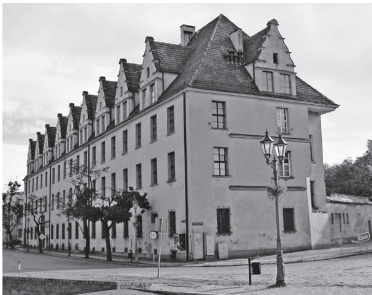
Obr. 13: Renesanční budova břežského gymnázia
