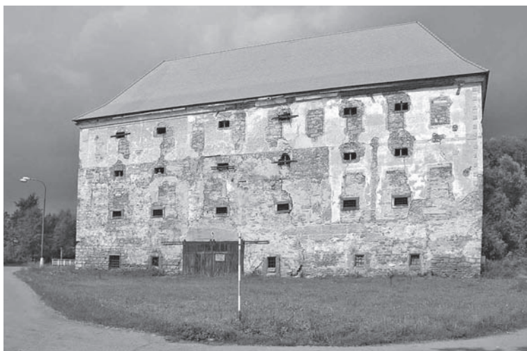
Obr. 4: Špýchar vzniklý přestavbou původní tvrze v Dohalicích
